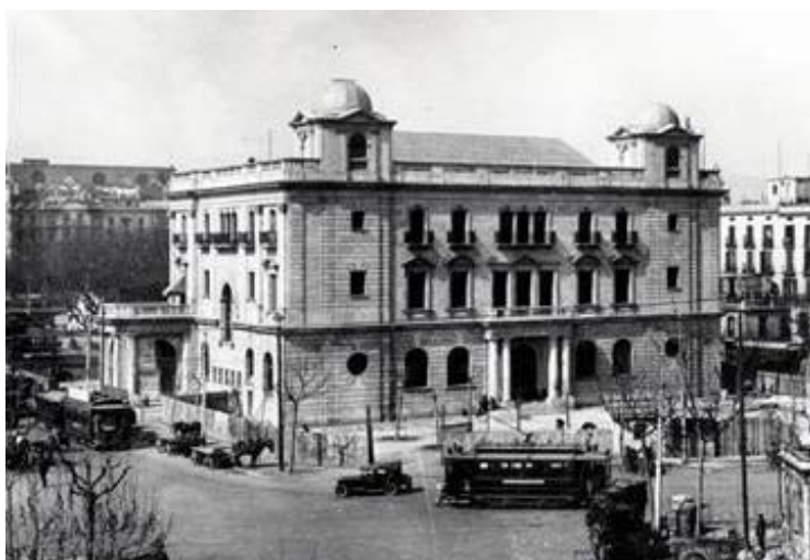
El edificio del Pla de Palau 18 data del 1932
